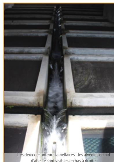
Les deux décanteurs lamellaires... les alvéoles en nid d'abeille sont visibles en bas à droite.
