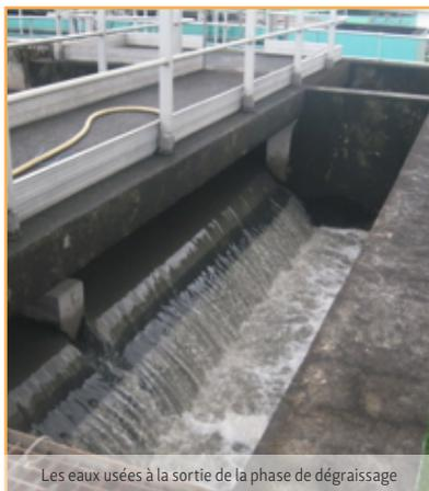
Les eaux usées à la sortie de la phase de dégraissage
