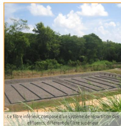
Le filtre inférieur, composé d'un système de répartition des effluents, différent du filtre supérieur
