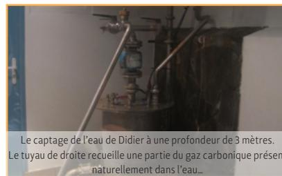
Le captage de l'eau de Didier à une profondeur de 3 mètres. Le tuyau de droite recueille une partie du gaz carbonique présent naturellement dans l'eau...
