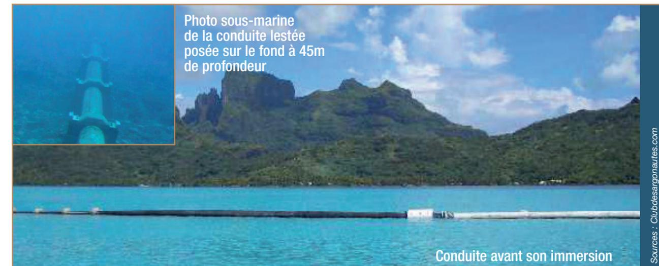
Photo sous-marine de la conduite lestée posée sur le fond à 45m de profondeur
