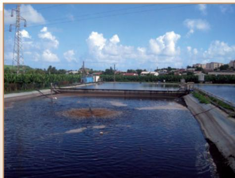
Le traitement se fait avec des bactéries en absence d'oxygène, il dégage du CO<sub>2</sub> et du méthane. Généralement, ce méthane, compte tenu des risques d'explosion, est récupéré et brûlé par torchères. Saint-James a choisi de valoriser ce méthane : il est brûlé dans un moteur qui entraîne une génératrice et permet donc de produire de l'électricité.
